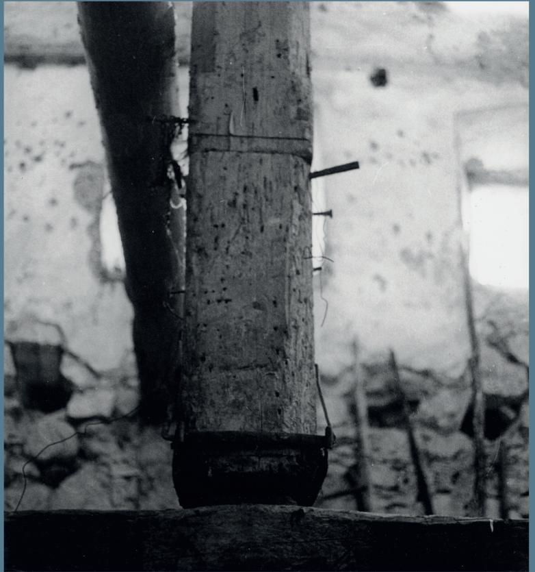
L'albero centrale del mulino di Pizzo nel punto in cui si incunea alla base nel maschio della ruota idraulica
